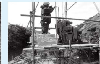
ボーリング調査
