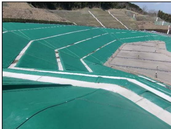
写真 6 表面遮水工の整備例
