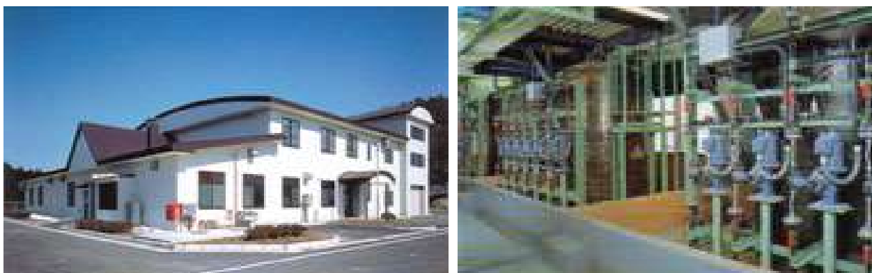
写真 2 浸出水処理施設の例（エコパークいずもぎき）
