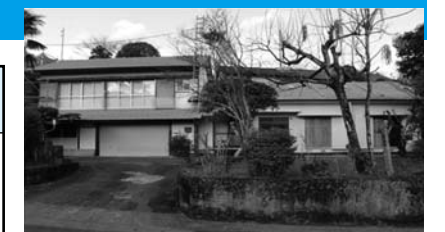
外観(※現在改修中)
