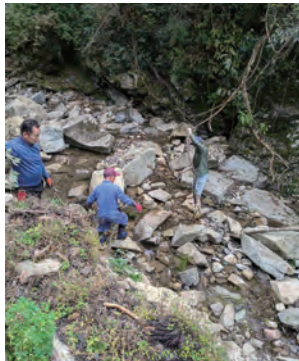
33体の観音像が並ぶ名所・観音滝の整備作業
