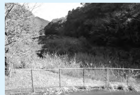
日向市最終処分場の調整池
