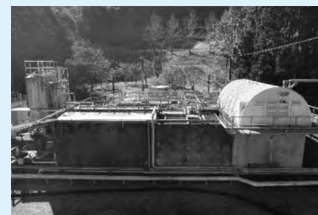
日向市最終処分場の浸出水処理施設
