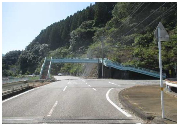
図 10 道路を跨ぐ橋梁の例（美郷町管理 南風谷歩道橋）
