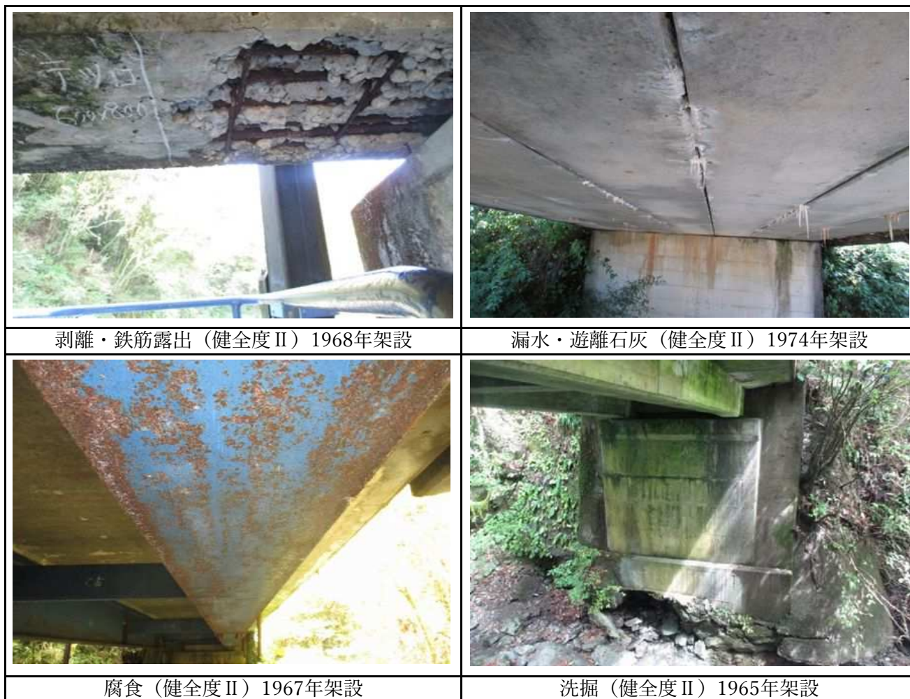
図 6 損傷状況
