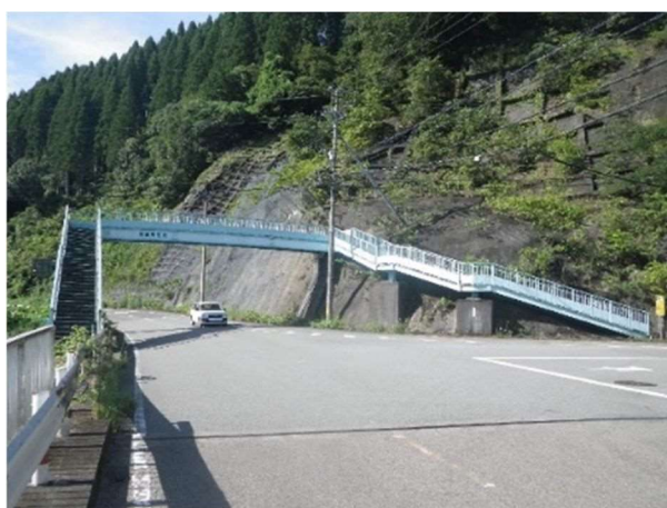
図 9 国道を跨ぐ橋梁の例（美郷町管理 南風谷歩道橋）
