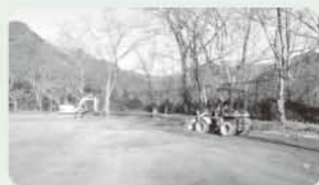
重機によるグラウンド整備
