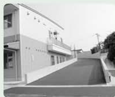
2階駐車場へのスロープ
