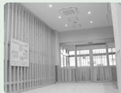
1階エントランスホール
