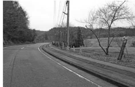
水道工事が進む入下地区
