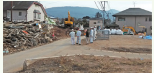
総務常任委員会熊本地震被害状況等調査
