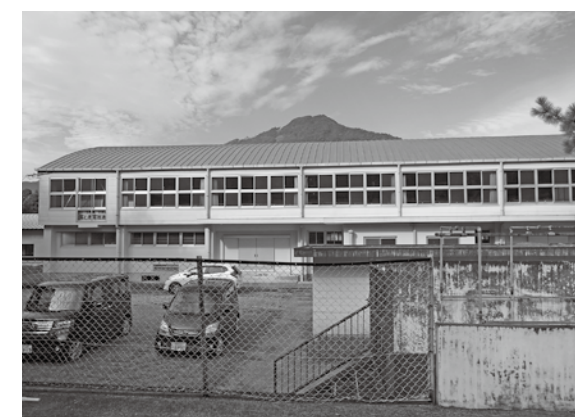
西郷中学校体育館(床・屋根)改修工事 4,746万3千円
