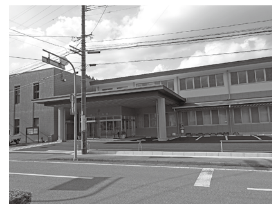
役場新庁舎(平成29年5月完成) 建設工事費(平成29年度への繰越を含む)6億3,121万9千円
