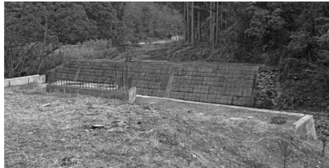
黒木・小黒木線2号橋上部工事現場
