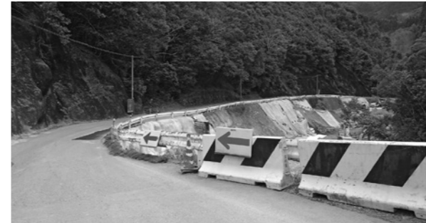
改良が進む国道388号西郷竹ノ平工区
