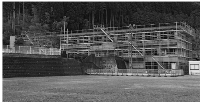
改修が進む旧黒木小学校
