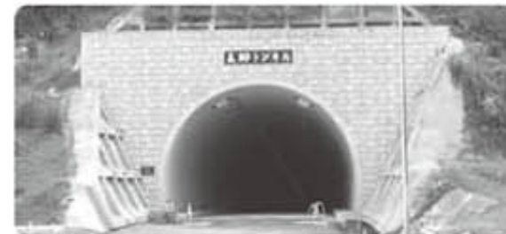
工事中の美郷トンネル
