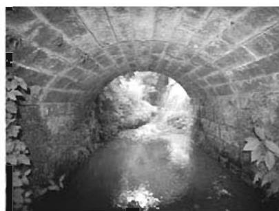
片平橋の内部上流部を臨む
