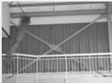
耐震補強ブレース(田代小)
