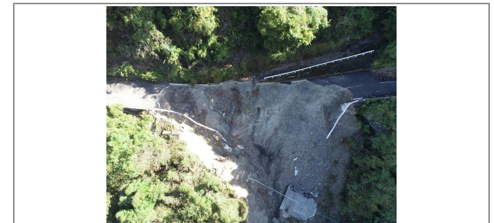
【状況写真②】 被災箇所(上空より)
