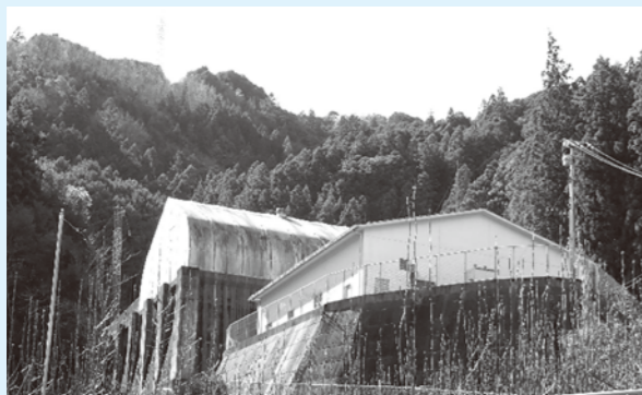
高吾北処理センター 全景
