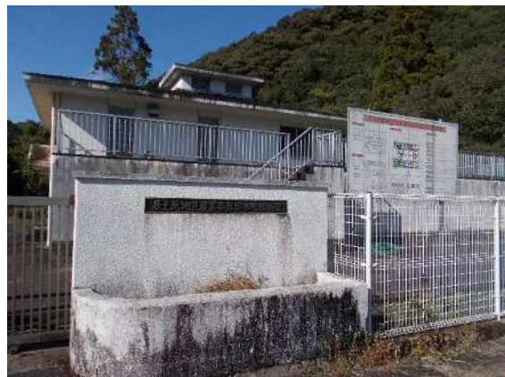
辰之元地区農業集落排水処理場
