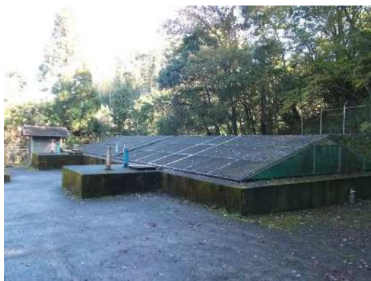
宇納間浄水場（緩速ろ過池）
