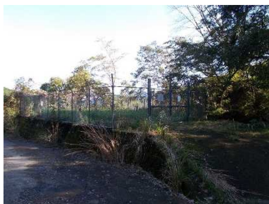
峰配水池（RC造）
