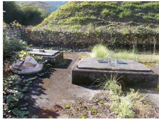
上野原水源（浅層地下水、浅井戸）
