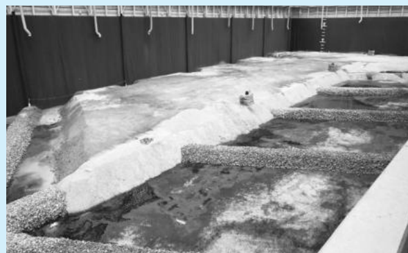
処分場内部(埋立状況)
