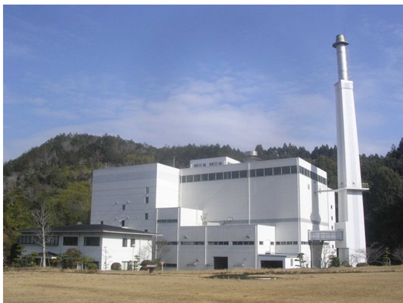
日向東臼杵広域連合清掃センター概況
