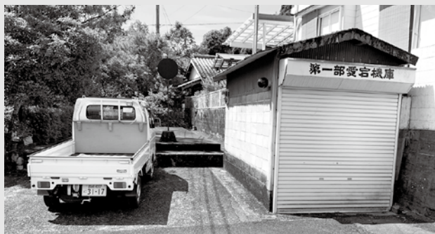
▲現在使用していない消防機庫の奥には防火水槽がある。消防機庫を撤去すると消火がスムーズに行われる。
