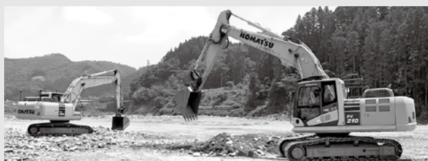
▲河川堆積砂利の除去状況
