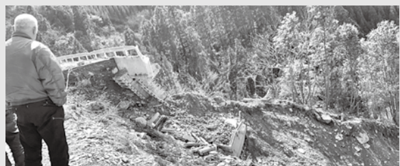
◀西郷中区の災害現場
